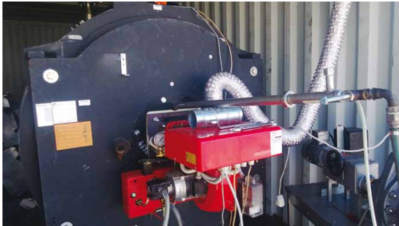
Рис. 1. Внешний вид котла Ygnis LRR 48/1400 с установленной дизельной горелкой и форсункой ВУТ
