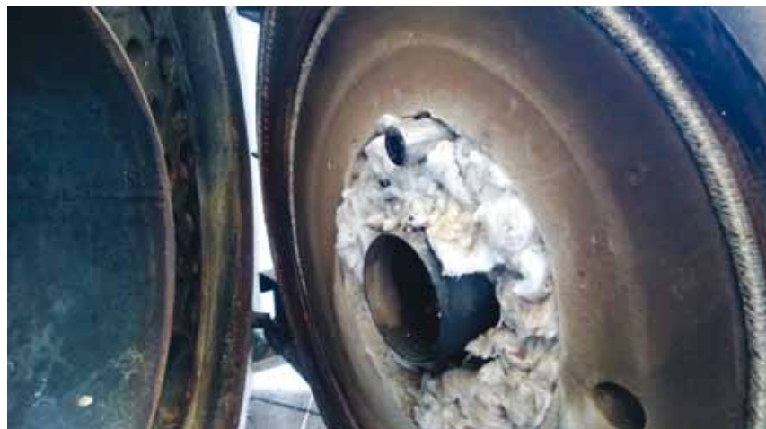
Рис. 2. Дизельная горелка и форсунка ВУТ со стороны топки котла
